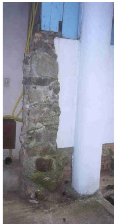
Figura 47 - Estrutura 11 Foto: Luana Periotto Costa, em 23 de set de 2004
