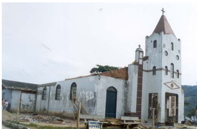
Figura 24 - Reforma do telhado (1998)
