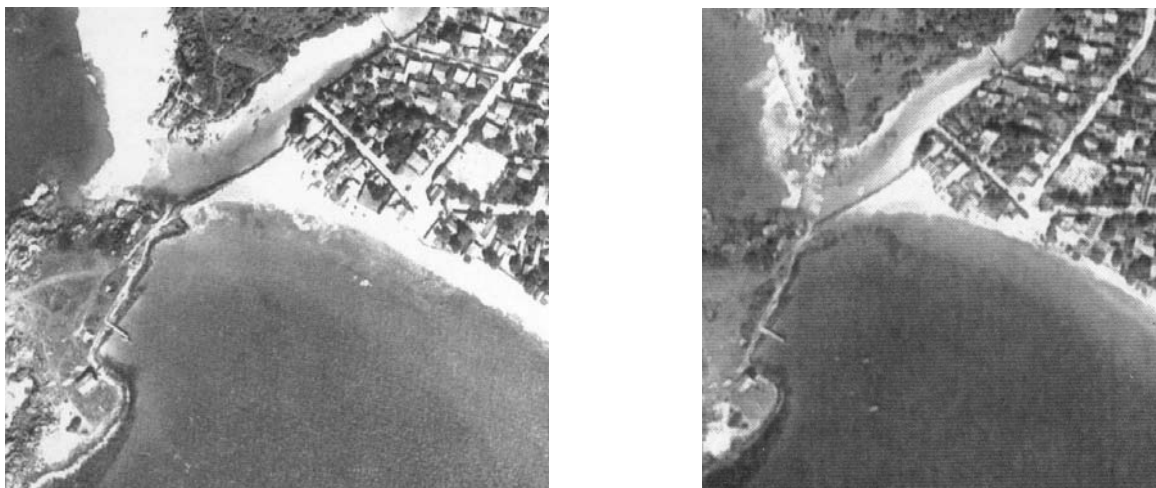
Figura 59 - Centro histórico da Armação – Foto aérea - 1994 e 1998 Fonte: IPUF
