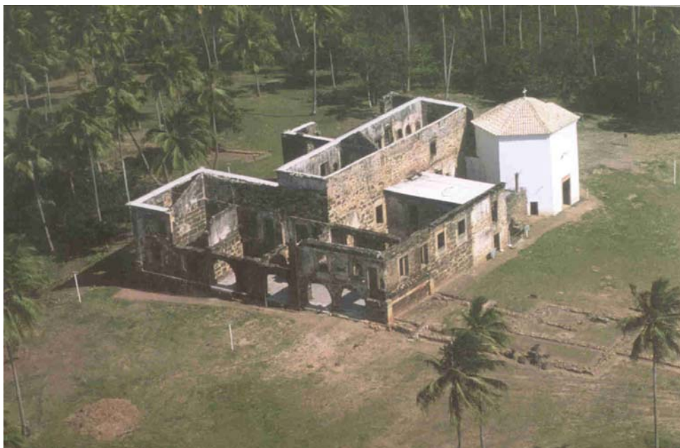
Figura 76 - Vista aérea da Casa da Torre Fonte: Holanda, 2002
