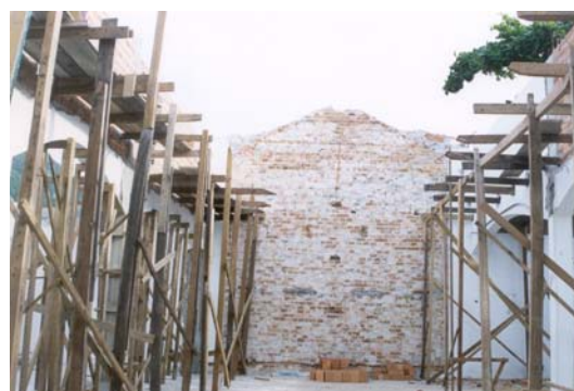
Figura 25 - Reforma do telhado (1998)
