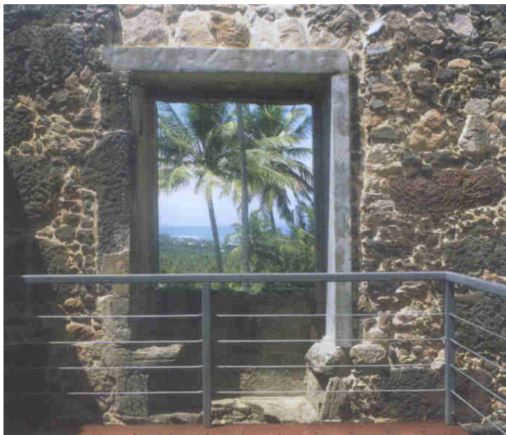
Figura 78 - Passarela de aço corten, recuada das alvenarias Fonte: Holanda, 2002
