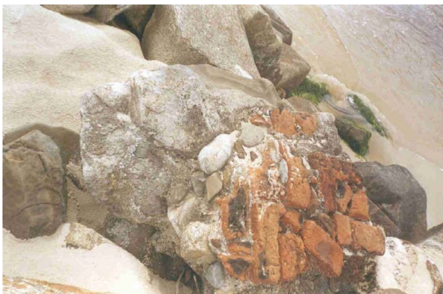
Figura 51 - Base de pilar deslocado para o molhe de acesso às campanhas por vândalos Foto: Luana Periotto Costa (2004)
