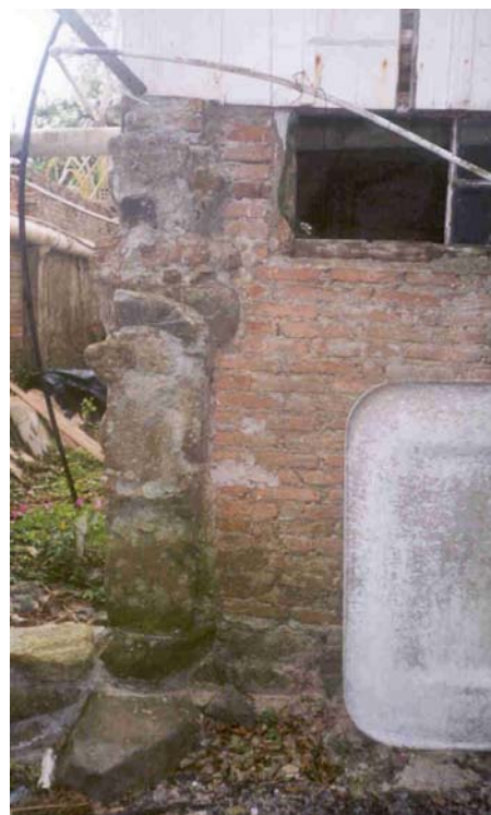
Figura 48 - Estrutura 12 Foto: Luana Periotto Costa em 23 de set de 2004
