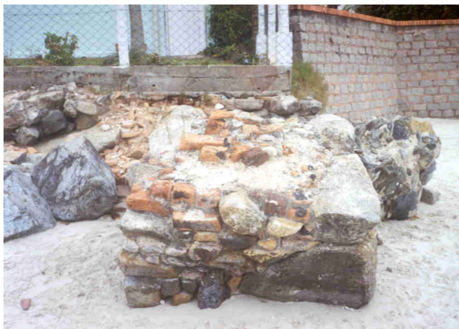
Figura 42 - Estrutura 05 Foto: Luana Periotto Costa em 23 de set de 2004
