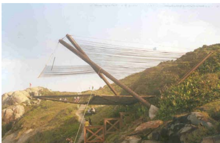
Figura 85 - Estrutura de proteção dos petroglifos Foto: Ivan Berticelli (2004)
