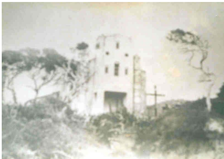
Figura 22 - Capela de Sant' Ana, já com a Torre Sineira (provavelmente década de 1960) Acervo: Capela de Santa' Ana
