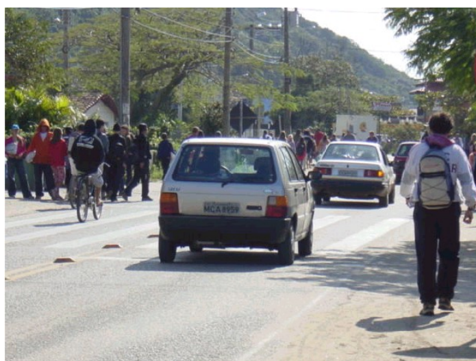
Figura 36 - SC-406 sem acostamento na praia da Armação do Pântano do Sul
