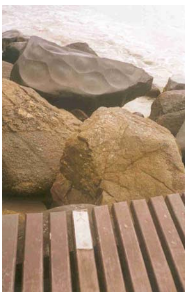
Figura 89 - Placas de sinalização indicativa no deck de madeira Foto: Ivan Berticelli
